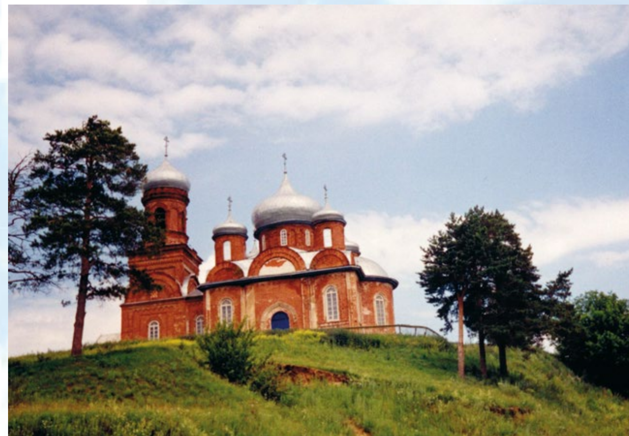
Петропавловская церковь в Криушах Фотография 2003 г.
