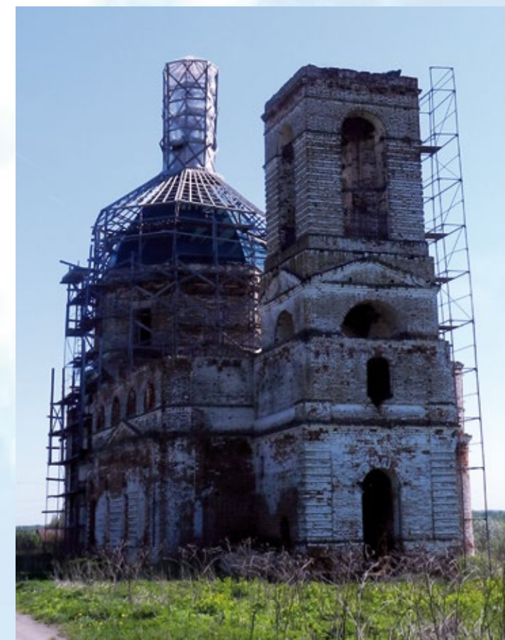
Тихвинская церковь в строительных лесах Фотография 2014 г.
